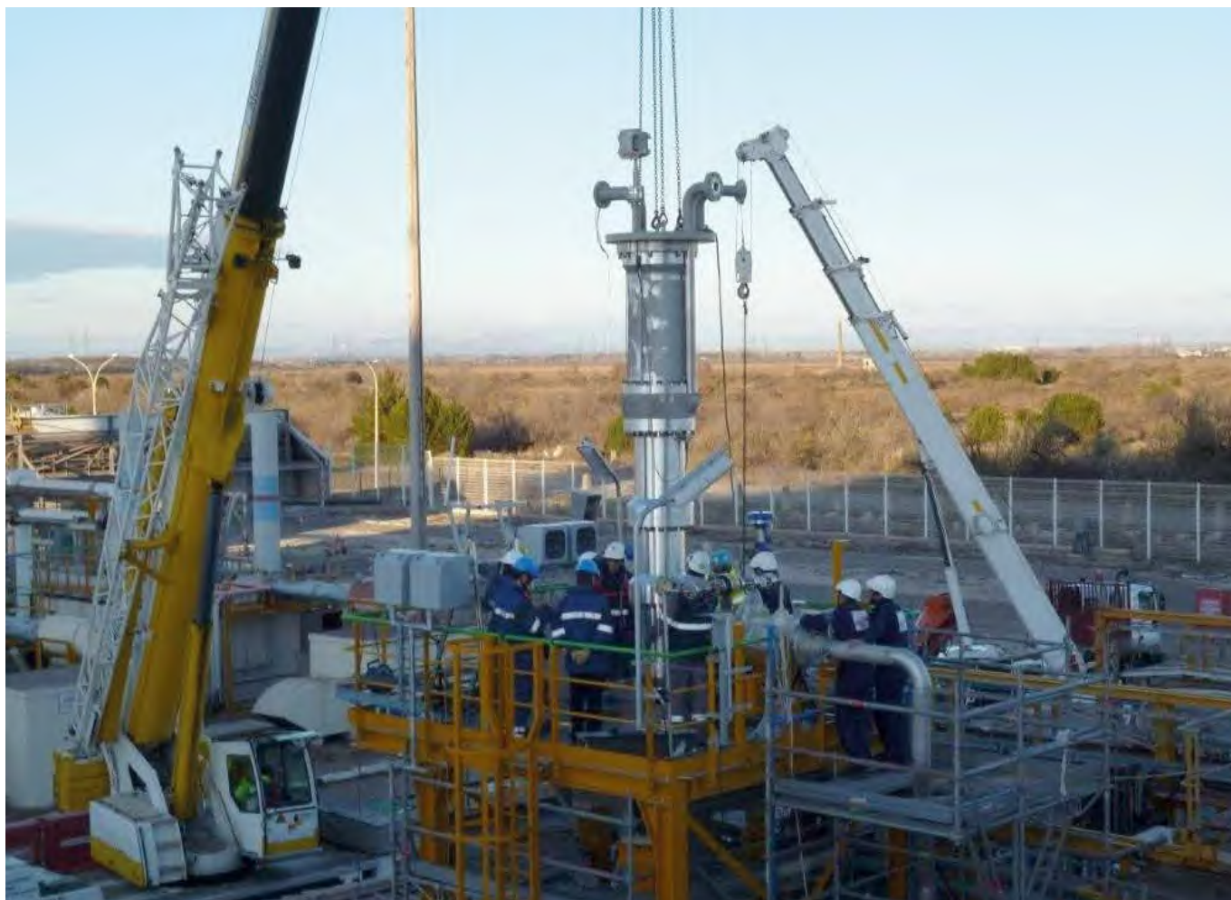
▲ Geveke bij installatie cryogene centrifugaalpomp van Nikkiso
