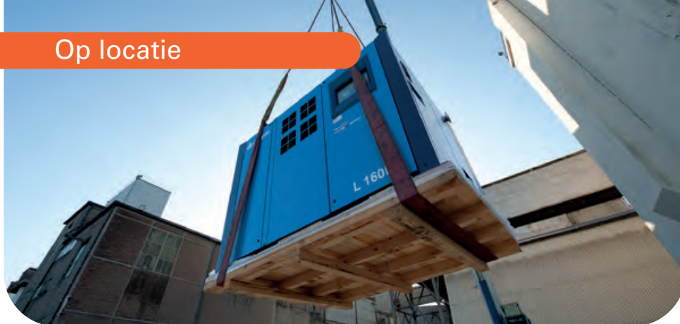
De nieuwe Frame 6 CompAir 160 kW oliegesmeerde toerengeregelde compressor is plug-and-play afgeleverd.
